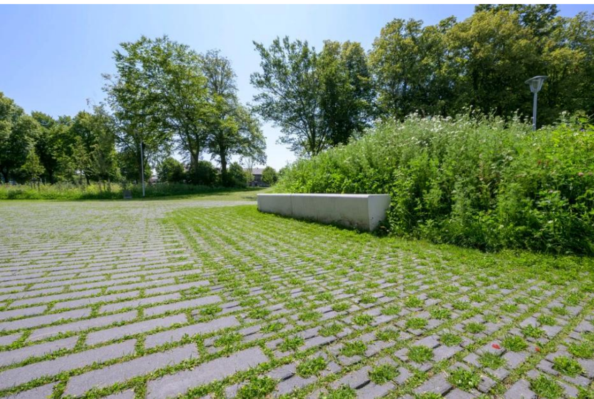
waterdoorlatende verharding van grasstenen met dichtere stenen op intensief gebruikte paden en opener stenen op extensieve plaatsen, leverancier MBI
